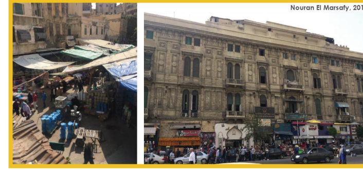
الصورة 4: إلى اليسار، صورة من سطح مبنى سوق ناصر تُظهر سوق نوال؛ وإلى اليمين، صورة تُظهر أحد مباني الوكالة، وهو مبنى تجاري تاريخي. المصدر: المؤلفة، 2018.
